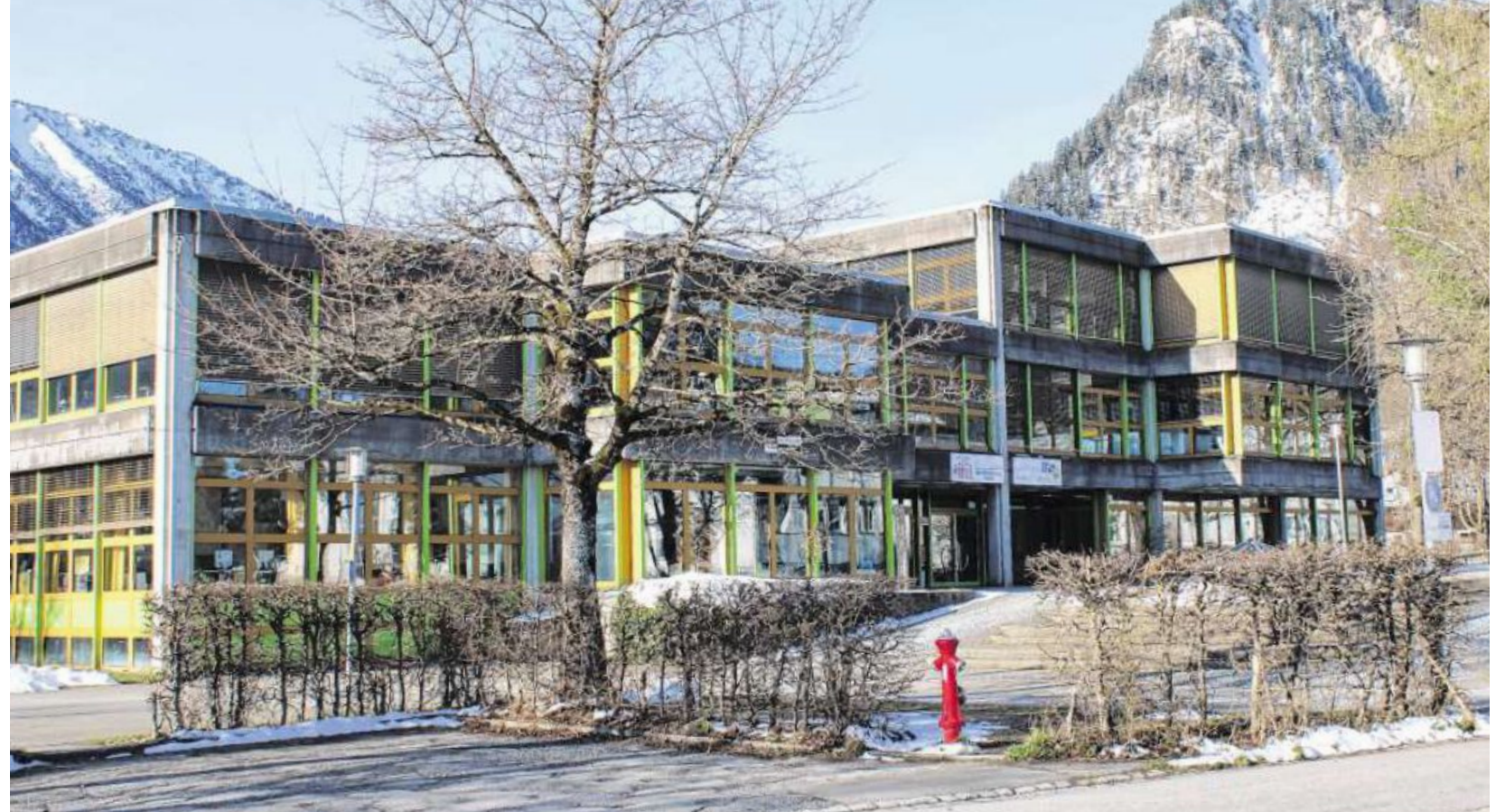
Bislang hat nur der westliche Flügel der Mittelschule Pfronten ein zweites Obergeschoss. Das soll bei der Sanierung auf der östlichen Seite ergänzt werden. Neben der energetischen Sanierung ist auch der Brandschutz bei den anstehenden Arbeiten ein wichtiges Thema. Foto: Markus Röck
